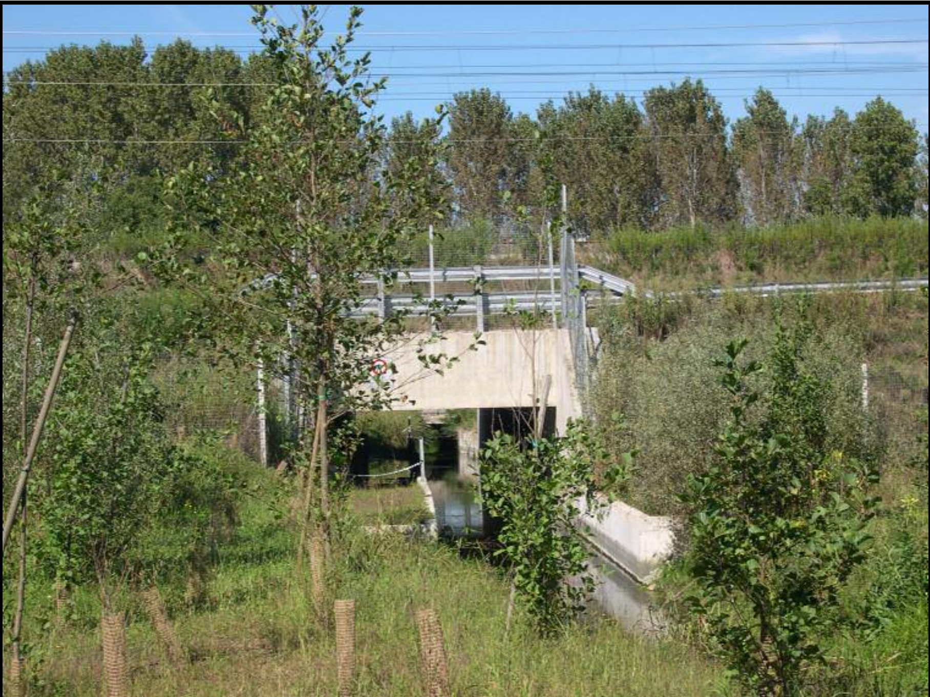
tombino scatolare m 5,5 x 3.0 – permeabilità per fauna terrestre ed acquatica
