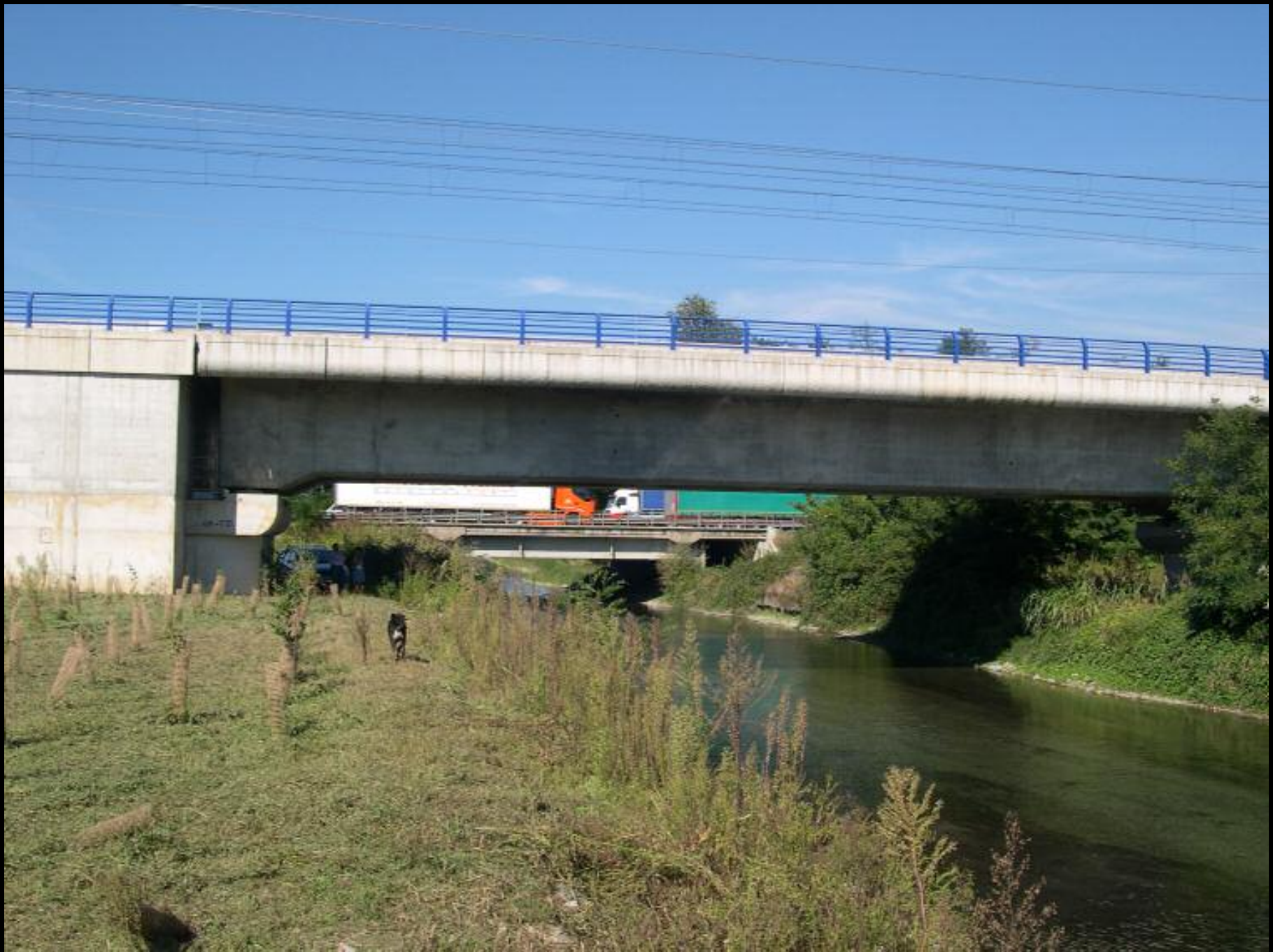
viadotto Naviglio Sforzesco, sullo sfondo il ponte dell'autostrada A4
