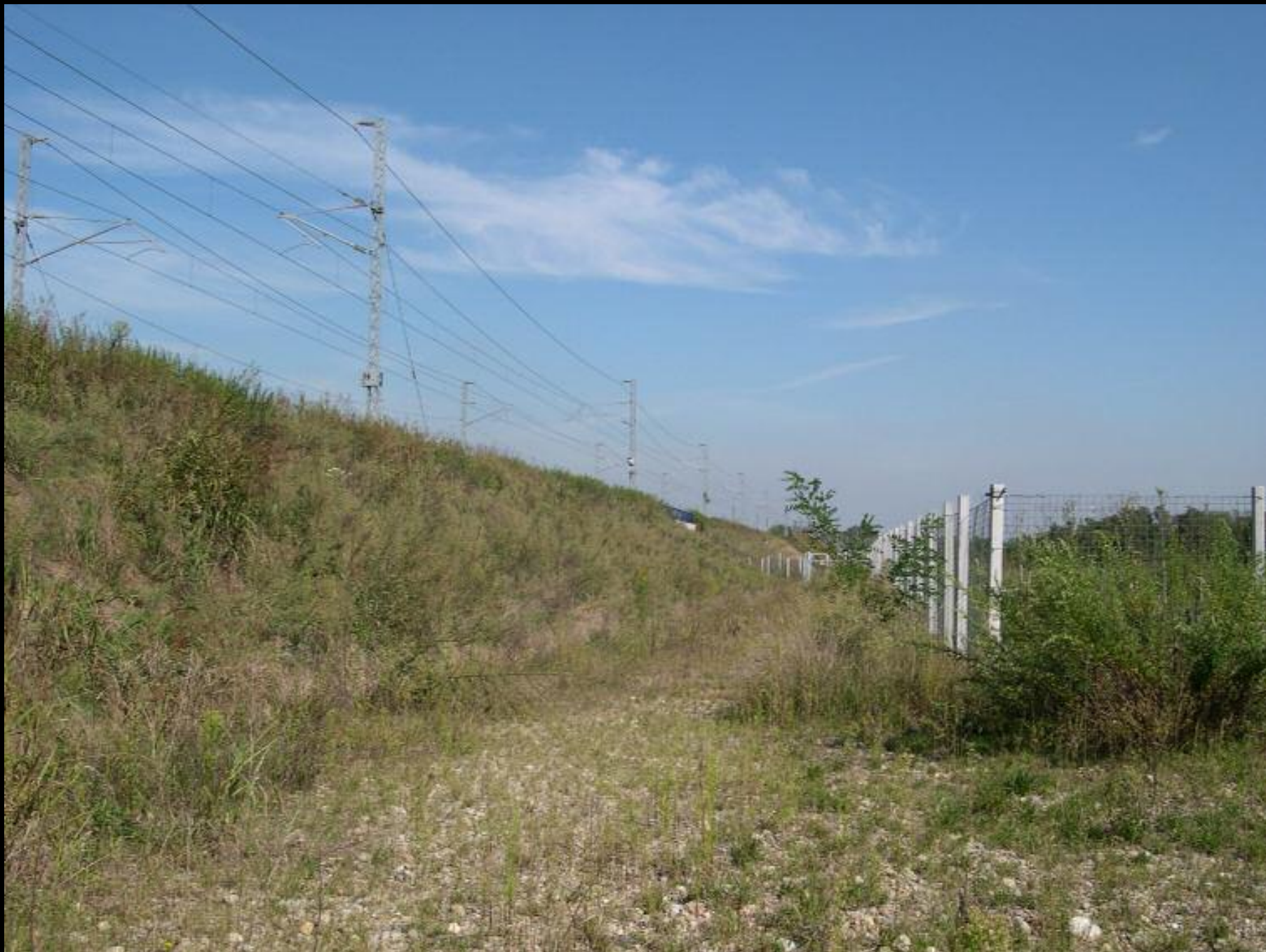
terrapieno e pista di servizio sterrata ed inerbita
